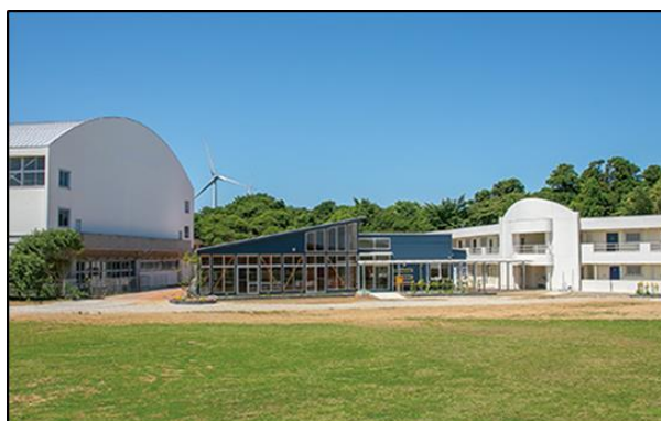
左から体育館（改修）、食堂・浴室棟（新設）、宿泊棟（部室棟を改修）
